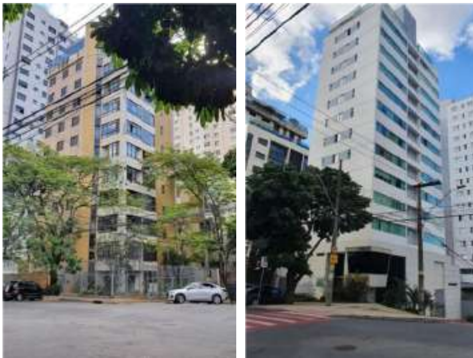
Figura 8 e 9: Exemplos de edificações construídas a partir da Lei de Uso do Solo de 1985 no bairro Funcionários
